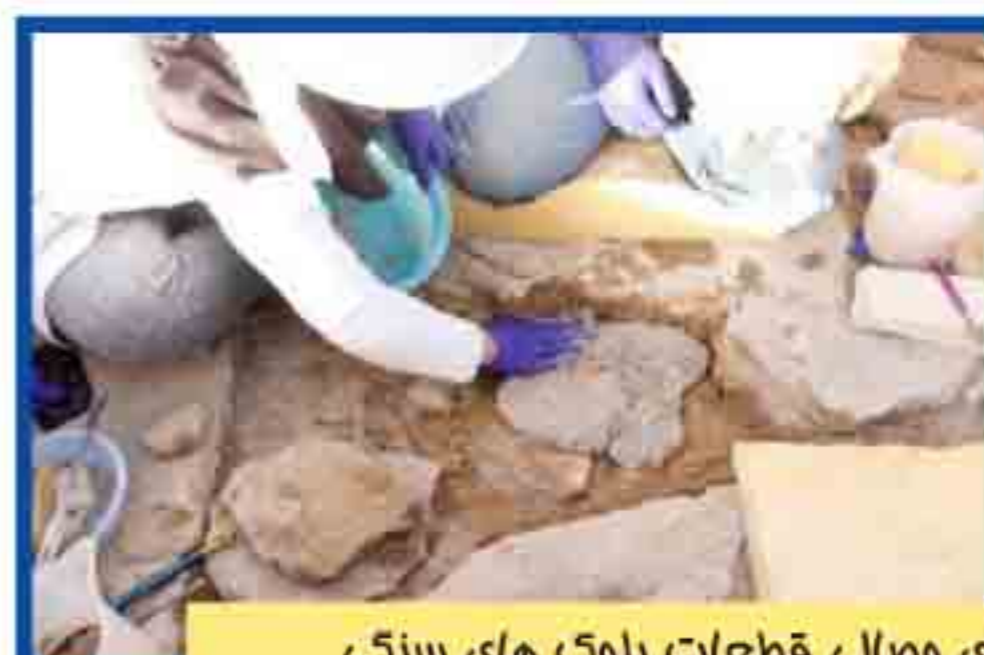
استحکام بخشی قطعات جدا شده بلوک های سنگی فندانسیون تالار کاف اختصاصی (با ملات پایه آهکی)
