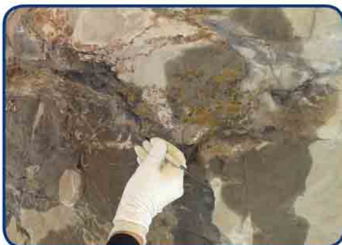
نمونه‌سازی پیش از اجرای ملات جهت انتخاب ترکیب مناسب از لاماژ رنگ، بافت و استمکام مورد نیاز ملات
