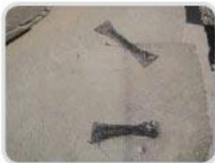
تصویر ۲: نمونه بست های دم چلچله ای تخت جمشید، مرمت های دوره هخامنشی
