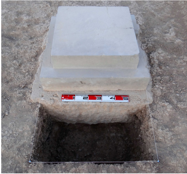
۲- نمایی از یکی از پایه‌ستون‌ها و شالوده زیر آن.
