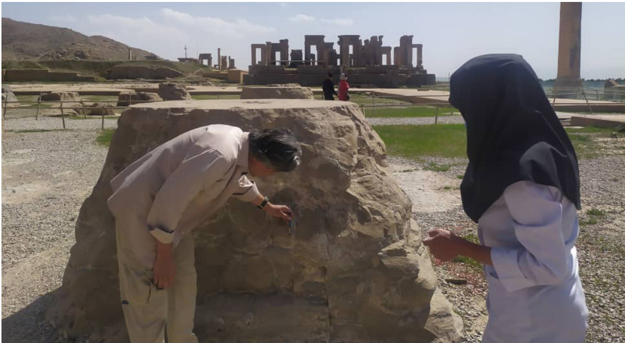
تهیه رنگ مناسب و تست اولیه روی ته ستون های مرمت شده
