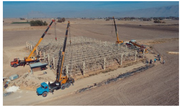
احداث پوشش حفاظتی سازه بزرگ دروازه پردیس پارسه، تخت جمشید، ۱۳۹۹
