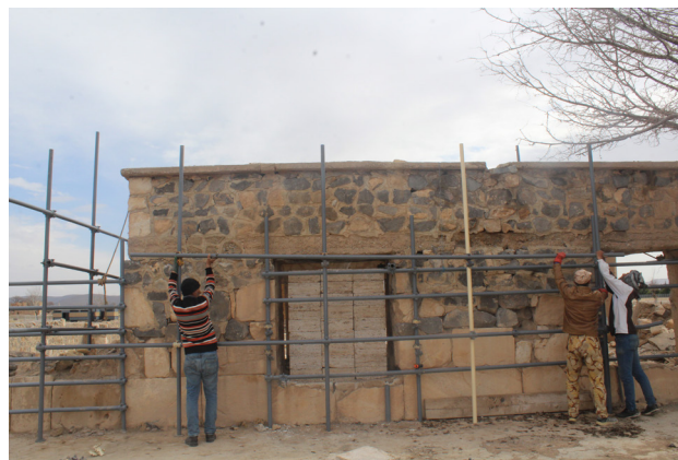
نصب لوله ها جهت زیر سازی سقف
