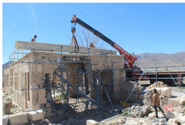
استفاده از جرثقیل جهت بالا گذاشتن صفحات ساندویچ پانل
