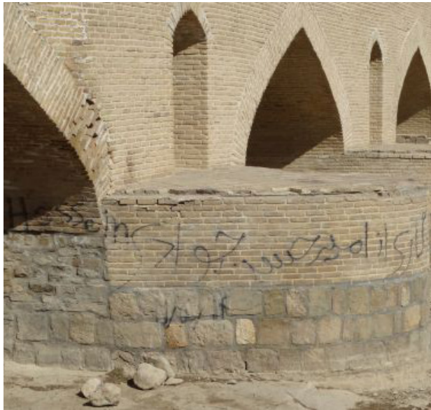
یادگاری های نوشته شده بر روی پل صلوات آباد در مسیر جاده بیجار به تکاب
