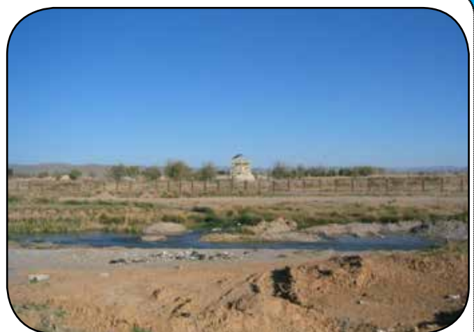
گابیون گذاری رودخانه پشت آرامگاه کوروش در سال ۱۳۸۲
