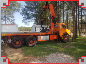
جابجایی اتاق نگهبانی در حفاری
