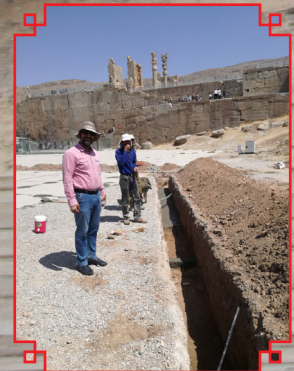
لوله گذاری جلوی پلکان ورودی
