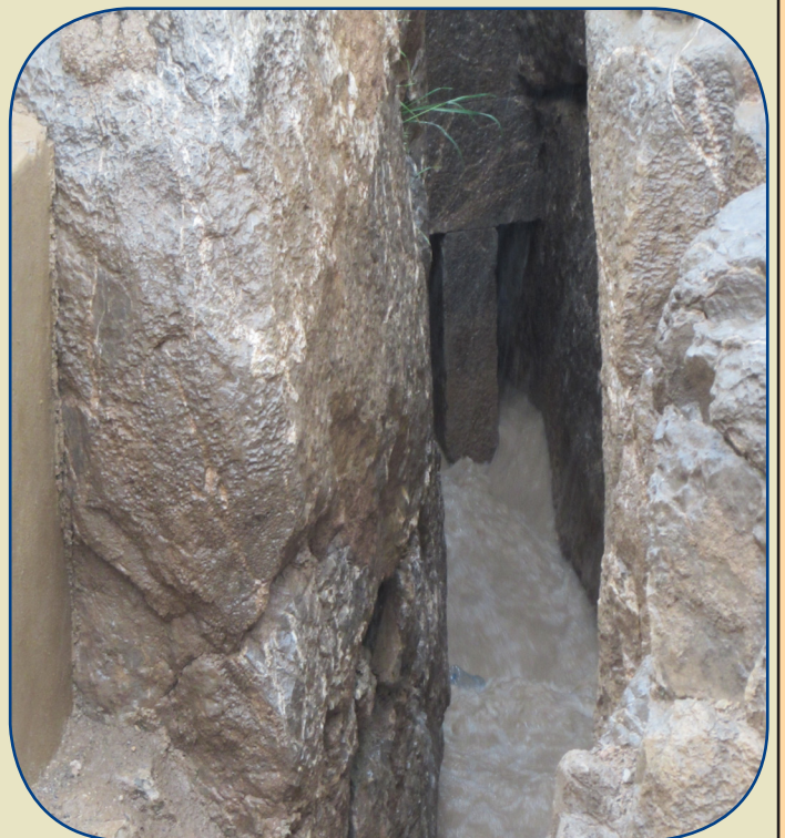
تصویری از خروجی آبراهه‌های تخت جمشید که در گوشه جنوب شرقی تختگاه قرار گرفته و آب تمامی شبکه کانال‌های زیر زمینی به آن منتهی شده و از آن جا به سمت پرزن جنوبی جاری می‌شود
