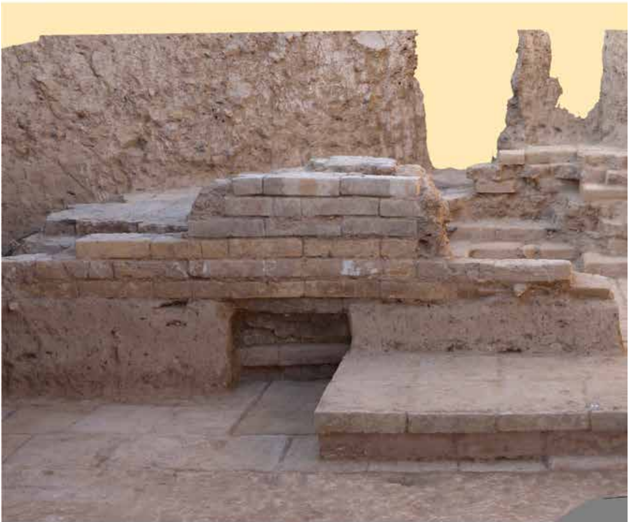
گمانه -11 بخش مرکزی محفوظ مانده از دیوار جنوب غربی فضای مرکزی که 11 ردیف آجر لعاب دار در محل اصلی بجای مانده را نشان می دهد: نمای کلی و جزئیات (گرافیک طرح: استفانو تیلیا).
